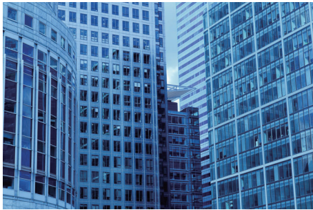
■商業ビル、オフィスの出入口
