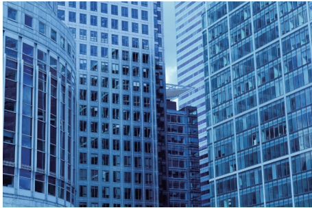
■商業ビル、オフィスの出入口
